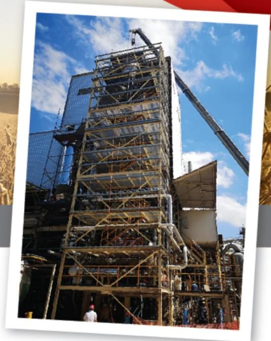
Integrado a este DT, se instaló un lavador húmedo (Scrubber), para substituir el existente que presentaba ineficiencia y deterioro debido a su antigüedad.
